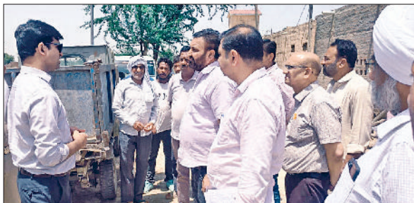
सिरसा। अमृत सरोवर योजना के तहत बन रहे तालाब का निरीक्षण करते एडीसी।
